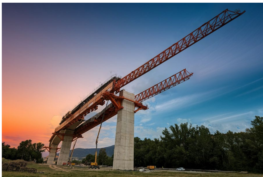
Autocimbra MSS 90 Zamora II en maniobra de avance de vano.
